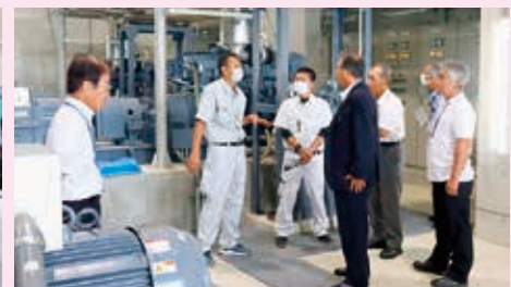
研修風景(於：荒浜第一排水機場)
