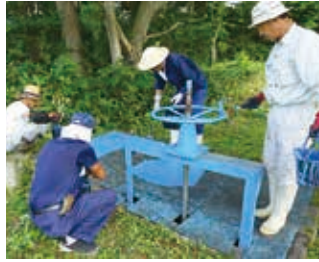
水門の塗装作業
