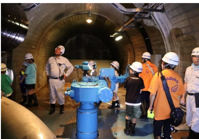
水窪ダム発電所管理トンネル内はこんな様子
