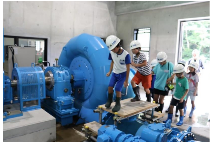
水窪ダム発電所内部見学
