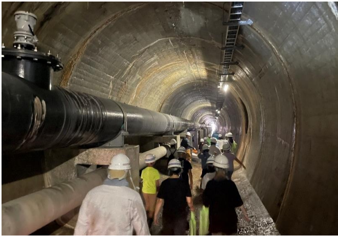
さあ、管理トンネルの外に出るよ
