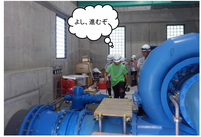
水窪ダム発電所内部見学
