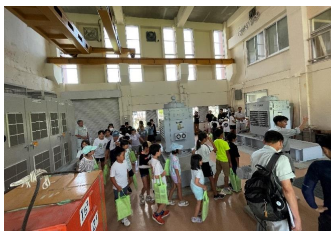
淞郷堰揚水機場の内部見学
