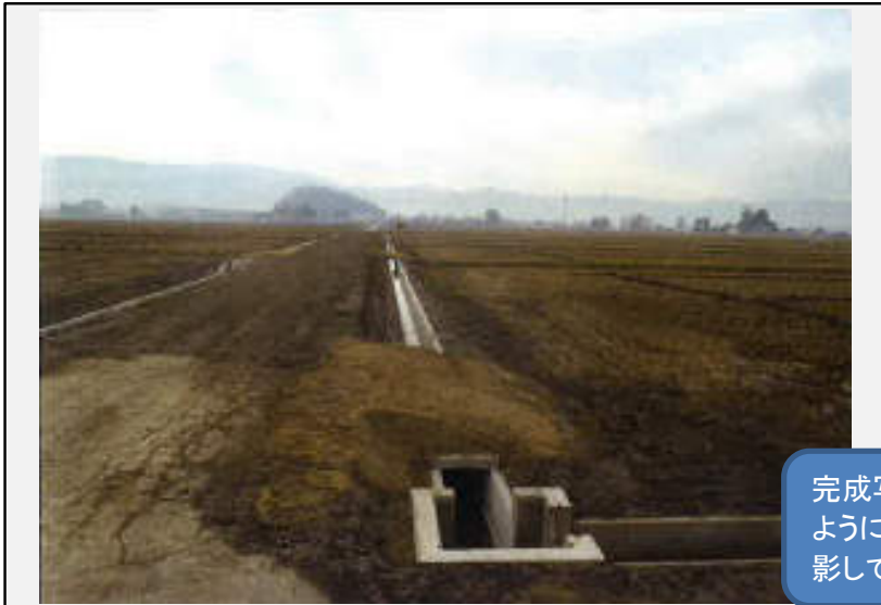
○○地区第1号用水路 始点 (完成)
