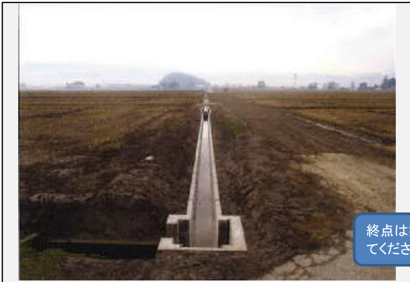
○○地区第1号用水路 終点 (完成)
