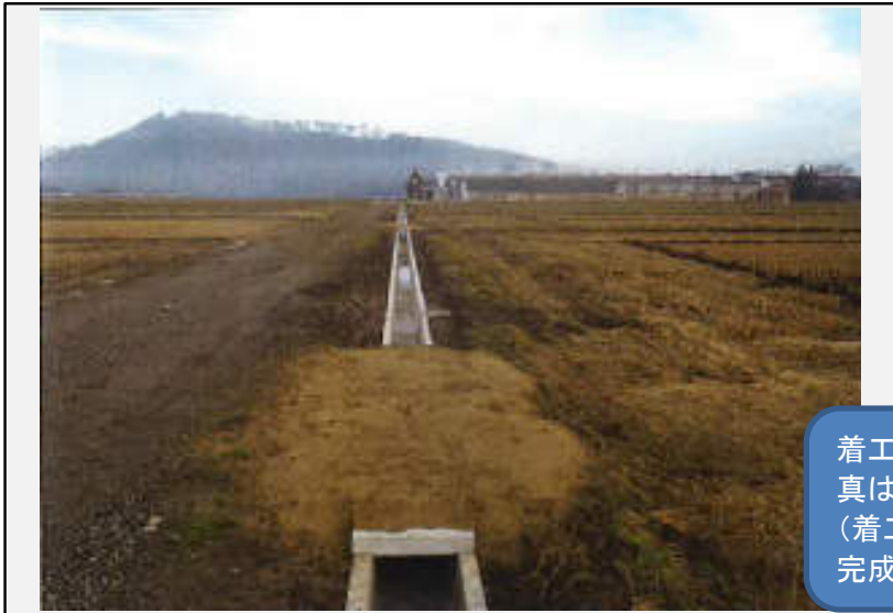
○○地区第1号用水路 中間 (完成)
